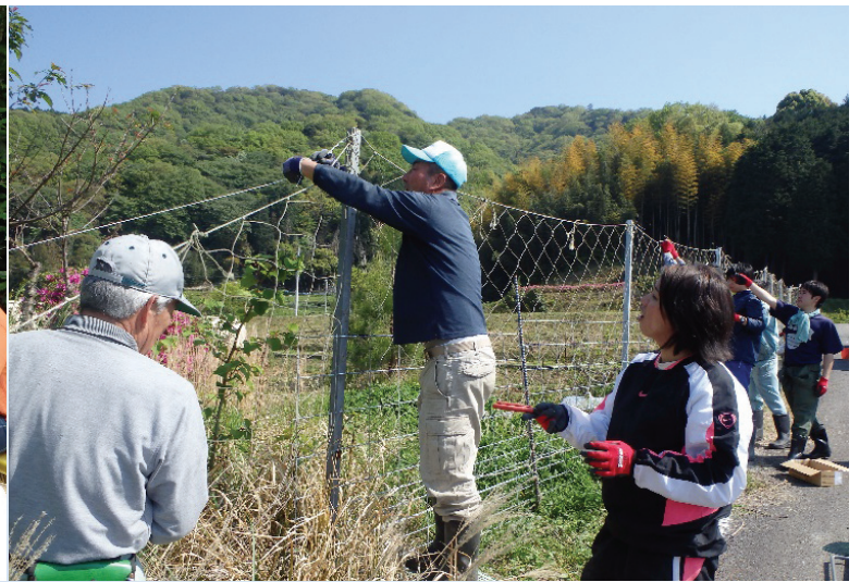
害獣侵入防止柵設置のお手伝い
