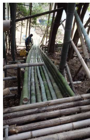
写真 3. 遊具補修作業
