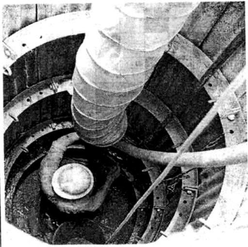
吉備国際大の文化財総合研究センターの基礎工事。学術フロンティア事業は、ここからスタートした
