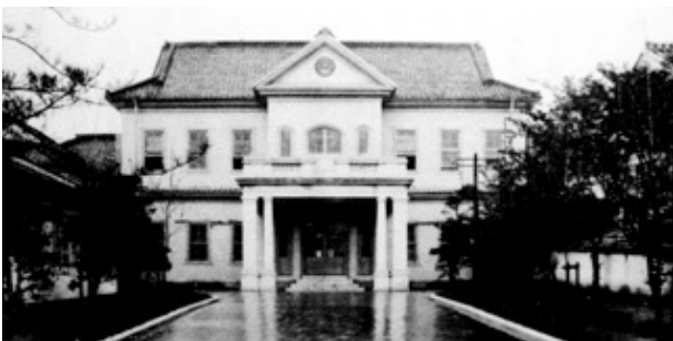
写真3 旧岡山県庁舎 22
